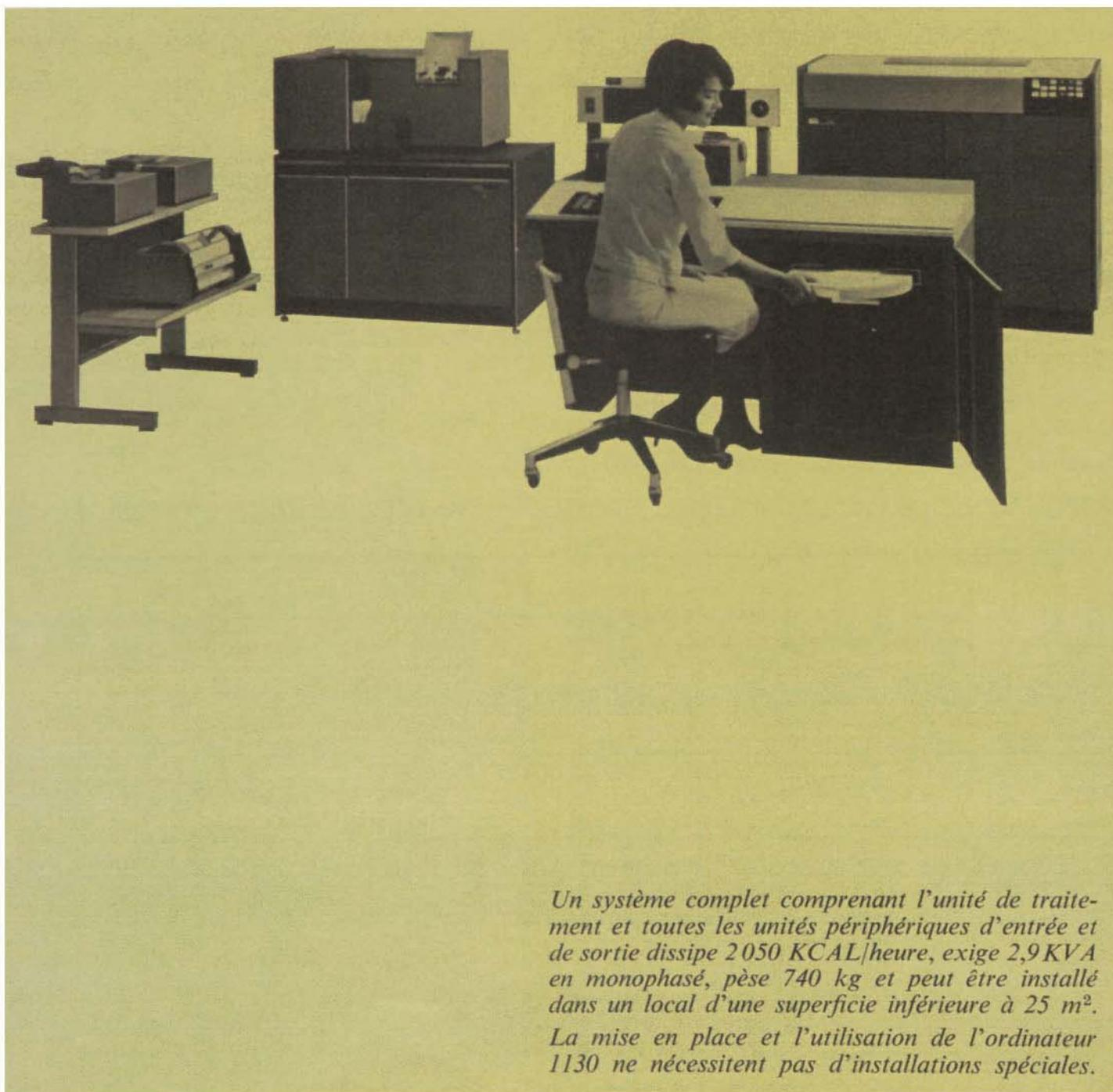
*Un système complet comprenant l'unité de traitement et toutes les unités périphériques d'entrée et de sortie dissipe 2 050 KCAL/heure, exige 2,9 KVA en monophasé, pèse 740 kg et peut être installé dans un local d'une superficie inférieure à 25 m<sup>2</sup>. La mise en place et l'utilisation de l'ordinateur 1130 ne nécessitent pas d'installations spéciales.*
