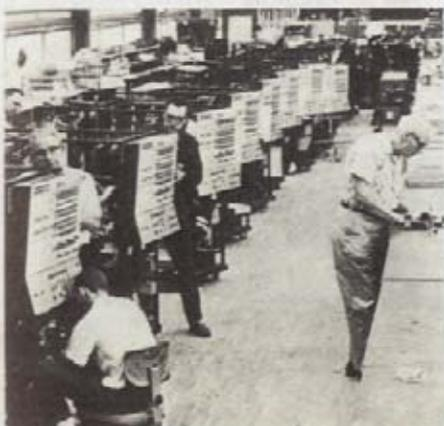
A determinação dos pontos onde as centenas de milhares de ligações eléctricas deviam ser feitas, foi uma das maneiras de utilizar os computadores IBM já existentes, para automatizar o «design» e a fabricação do Sistema/360. Também se aperfeiçoaram dezenas de outras técnicas novas de desenvolvimento e fabricação.
